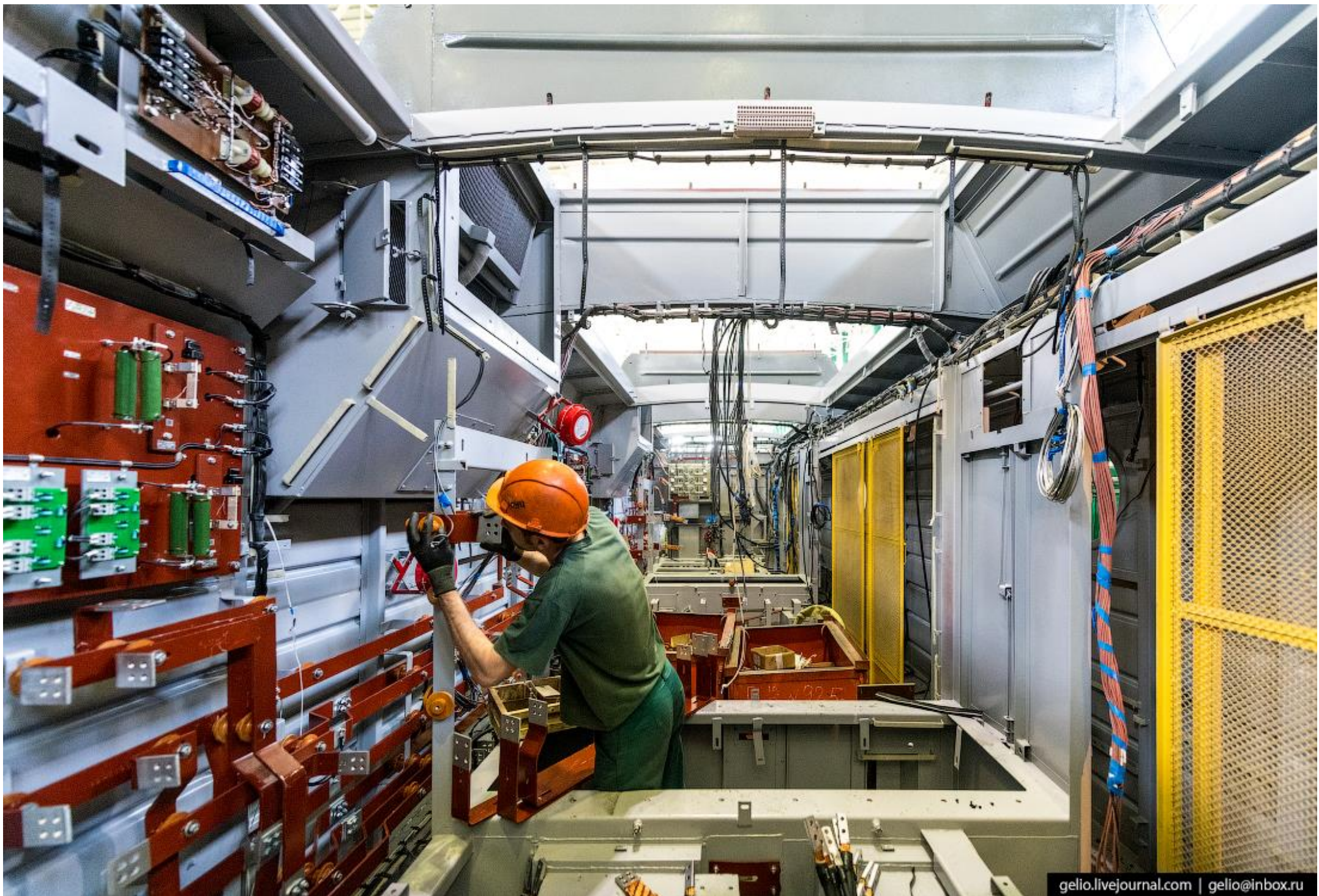
Монтаж силовых шин
